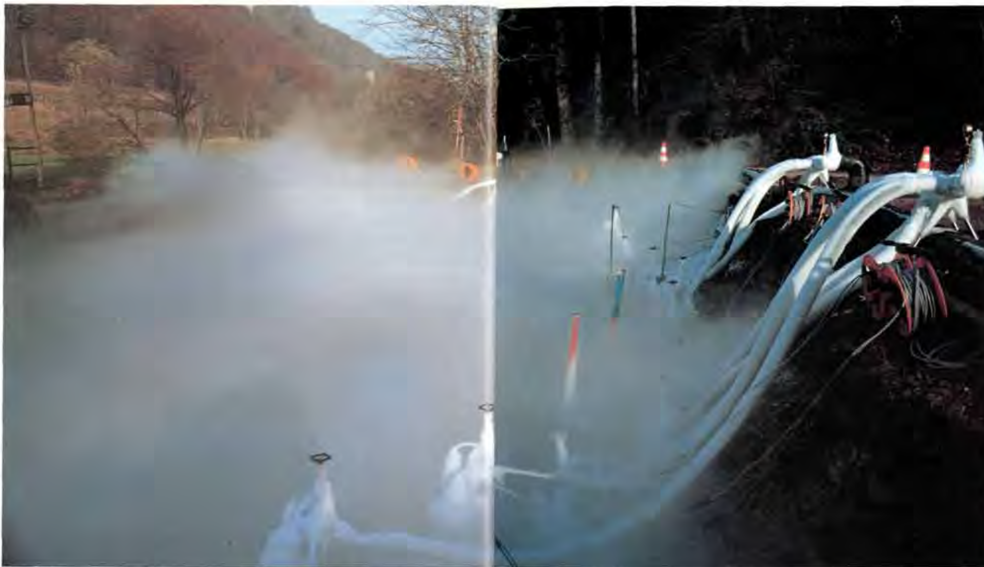
Das Gefrieren von Erdreich mit flüssigem Stickstoff verhindert den Einsturz von Baustellen und das Eindringen von Grundwasser
