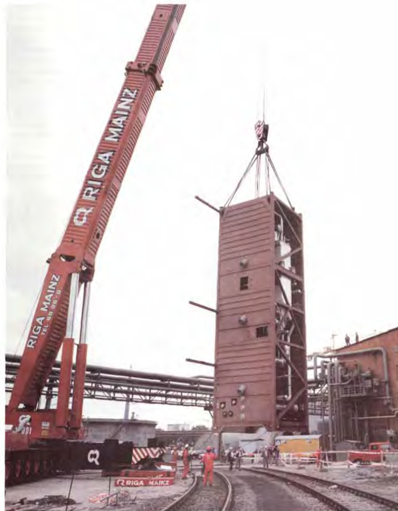
Wir investieren 50 Millionen DM in den Bau der Luftzerlegungsanlage Frankfurt-Höchst
