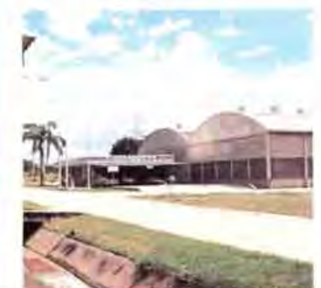
Messer Griesheim de Venezuela hat die zweite Produktionshalle errichtet
