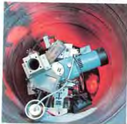
Korrosionsschutz durch Unterpulverschweißtechnik: Behälter und Rohre werden bandplattiert
