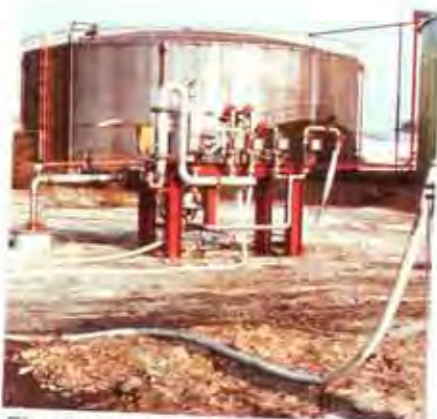
Eine kostengünstige Art der Sanierung verunreinigter Böden ist der biologische Abbau mit Sauerstoff
