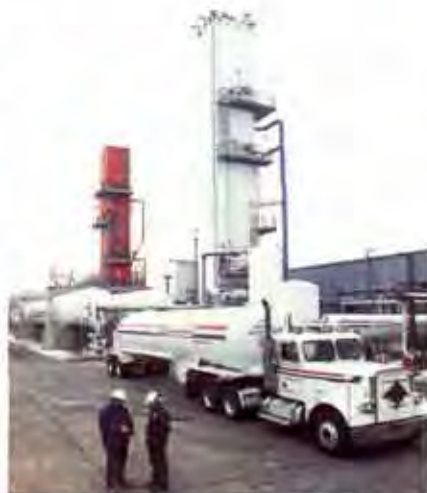
In Reading/Pennsylvania hat MG Industries eine zweite Luftzerlegungsanlage gebaut
