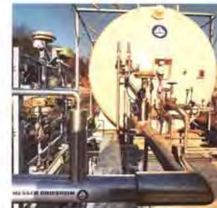
Für einen Raketenprüfstand lieferten wir Sauerstoff- und Wasserstofftanks sowie das Rohrleitungssystem
